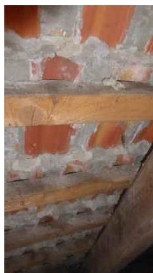
Abb.13 – weitgehend verschlossene Fugen zwischen den Dachziegeln
