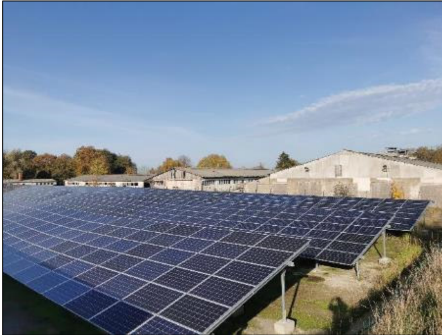
Abb. 17: PVF im südlichen Geltungsbereich (Foto 10.04.2022).
