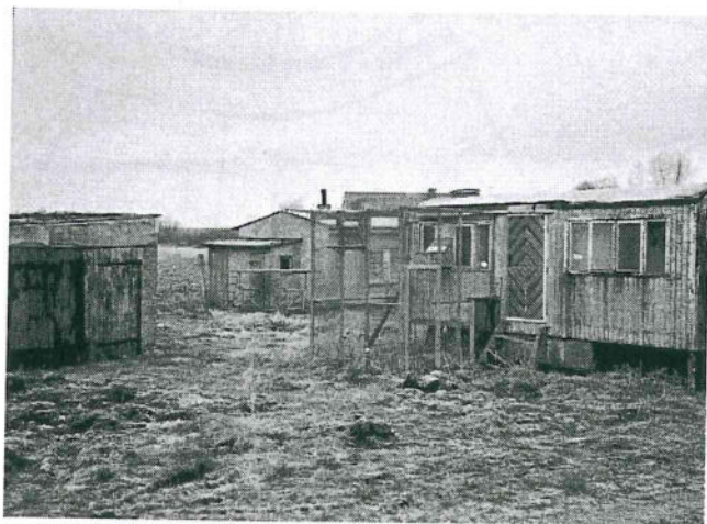
Nebengebäude, Bauwagen im südlichen Teil der Fläche
