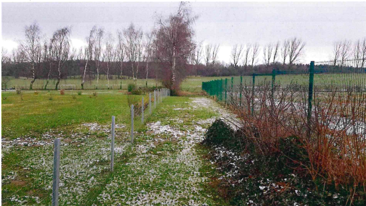
Foto 13: Blick von der Straße in Richtung SO 1 – Gebiet – rechts Anlagen des Zweckverbandes
